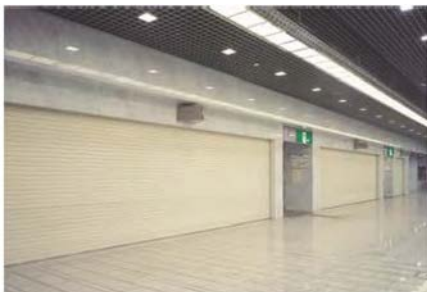
地下街の重量シャッター
