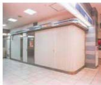
軽量横引きシャッター
